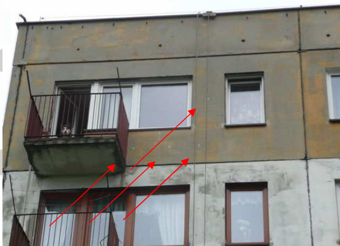
Rys.10. Miejsca wykonanie kontrolnych odwiertów na jednej z płyt [5].
